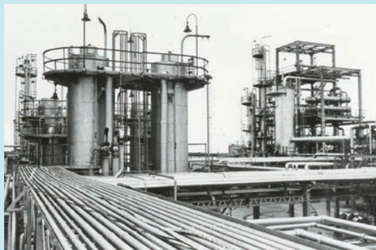
エチレン工場
