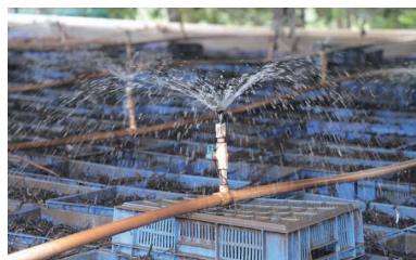
ミミズ養殖の技術を用いた排水処理の様子
