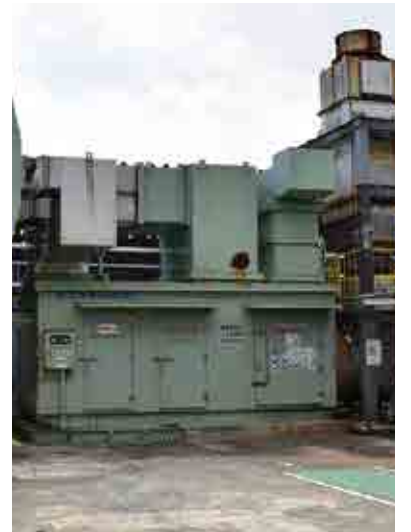
ガスタービン・コージェネレーションシステム ●役割/自家発電、蒸気製造
