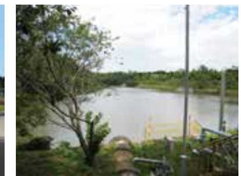
調整池(桜ヶ池)
