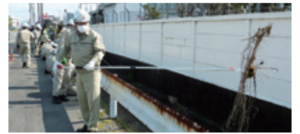
西側 町用水路の清掃
