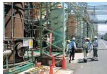
工事安全パトロール
