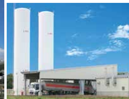
LNGサテライト(LNGタンク設置)
