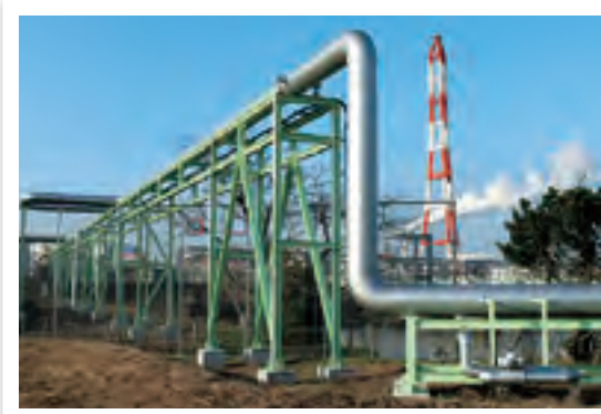
王子マテリア(株)大分工場から供給を受けている蒸気の配管
