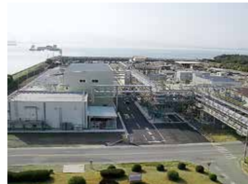
排水処理設備
