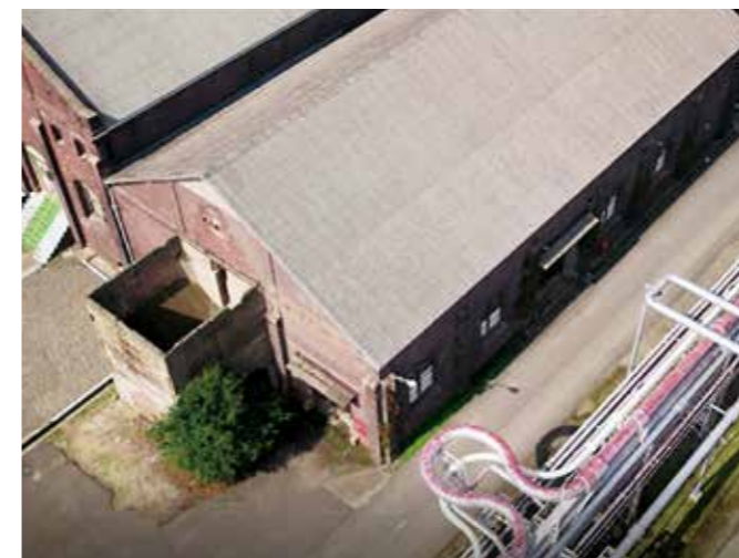
倉庫屋根点検
