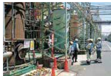
工事安全パトロール
