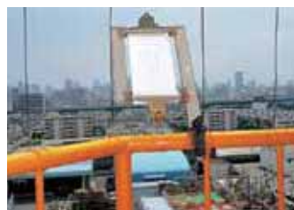
白布モニター（粉じん飛散監視）
