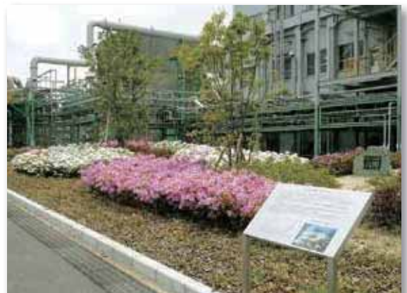
焼却炉撤去跡
