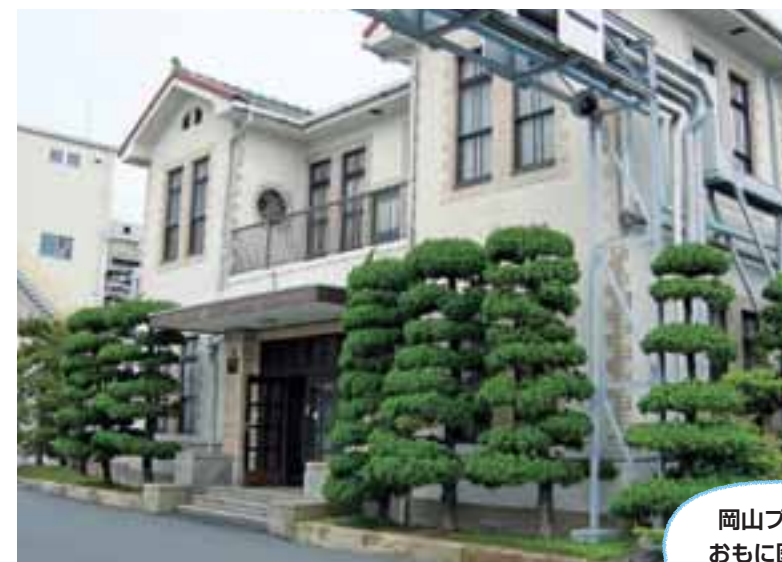
本館事務所(1915年建築)
