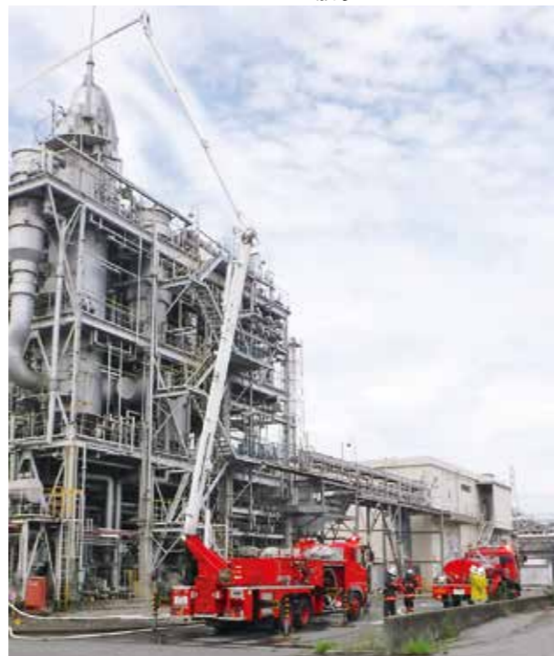
プラントへの放水
