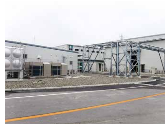
旧建屋から耐震建屋への建て替え
