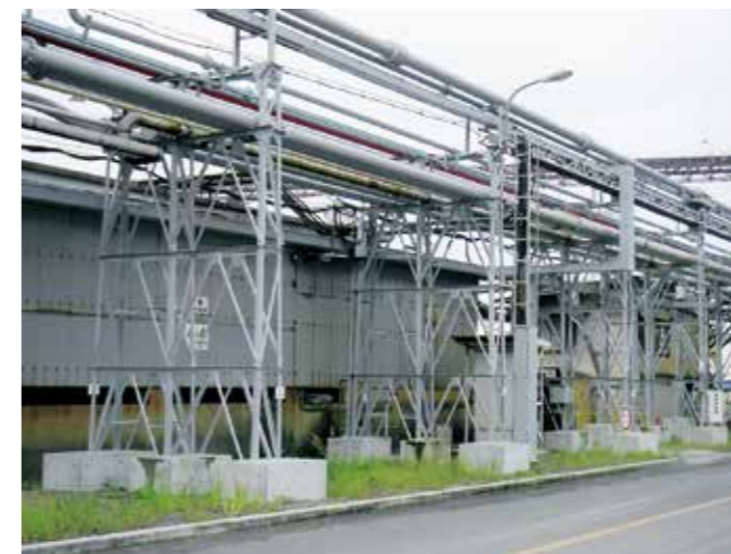
パイプラックのコンクリート補強
