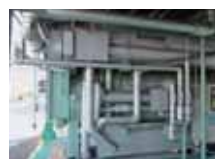
※3 蒸気吸収式冷凍機
