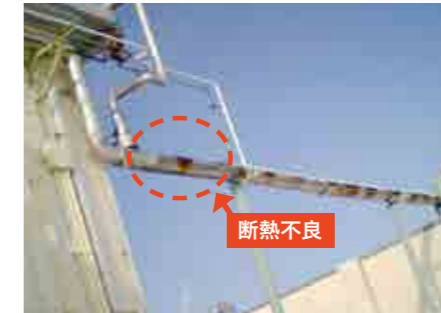
蒸気配管の断熱材(写真1)
