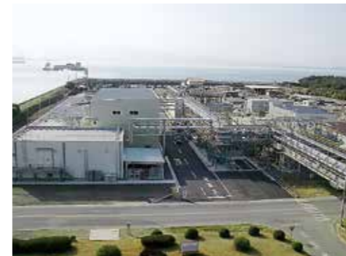
排水処理設備
