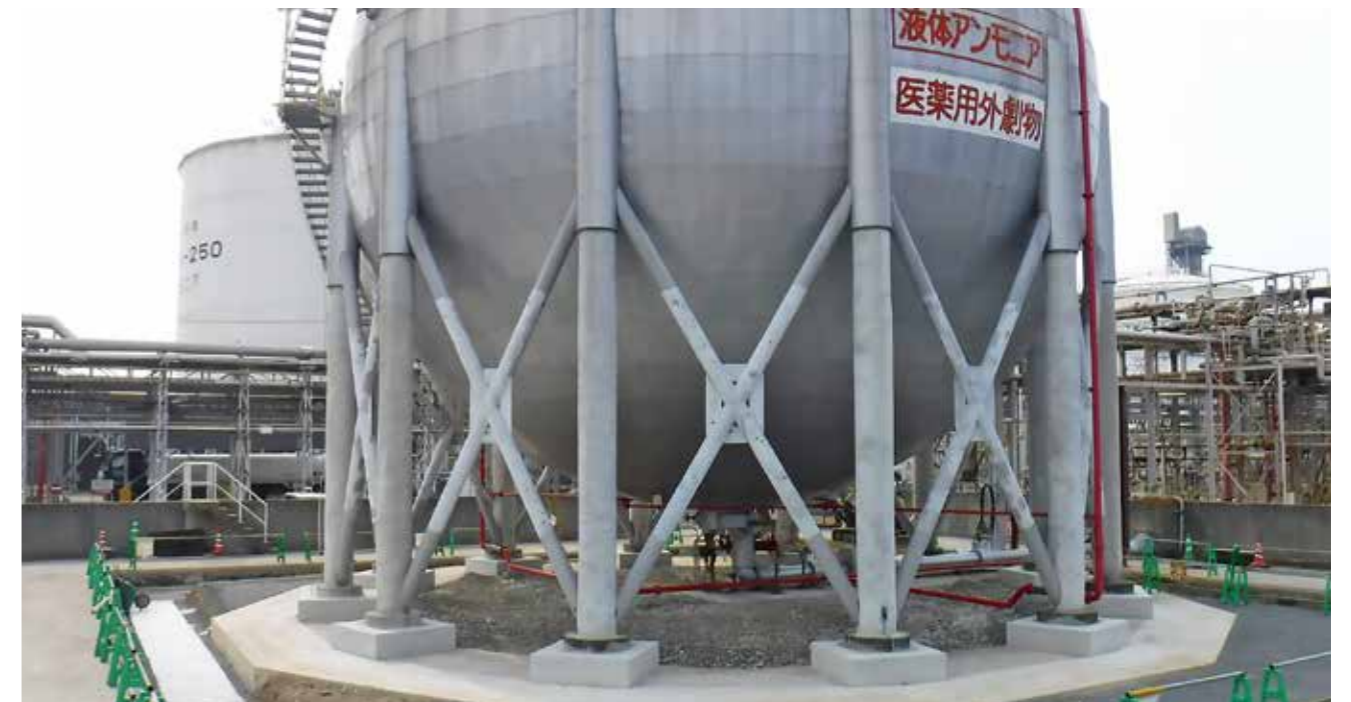
球形タンクの耐震補強
