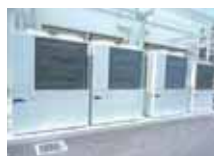
※3 ガスヒートポンプ
