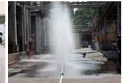
防災班による水幕設備設置
