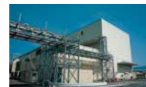
耐熱セパレータ工場
