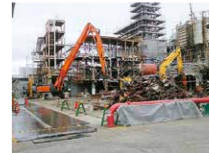
高経年化設備解体
