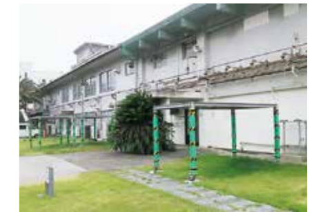
屋外避難シェルター設置
