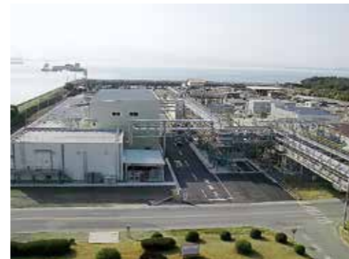
排水処理設備
