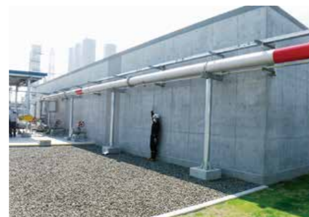
消防用貯水槽
