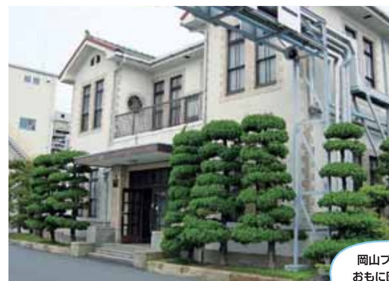
本館事務所(1915年建築)
