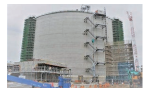
建設中の国内最大級のLNGタンク (愛媛工場敷地内)
