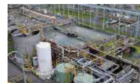
活性汚泥処理施設
