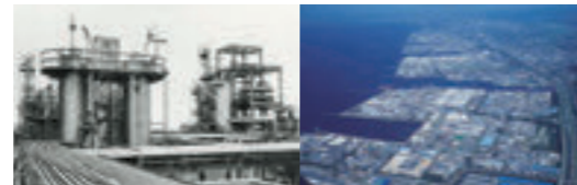
大江工場 (エチレンプラント) 千葉工場
