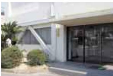
耐震用の梁(鉄骨)で補強した愛媛事務所
