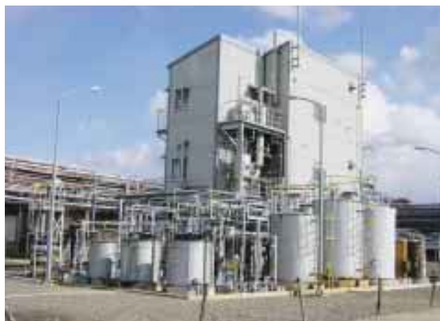
塩酸酸化の試験製造設備
