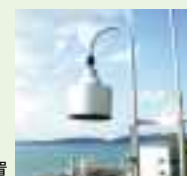
水銀灯に傘を設置
