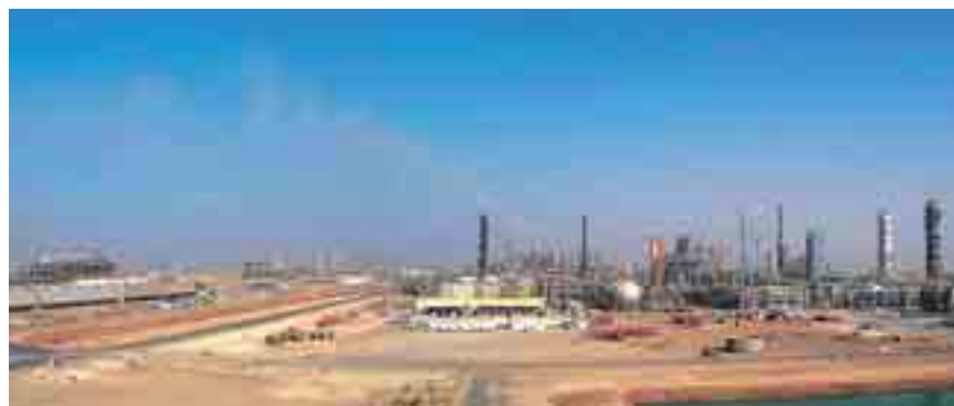
2008年第4四半期の商業運転開始に向けて着々と工事が進むラービグのプラント
