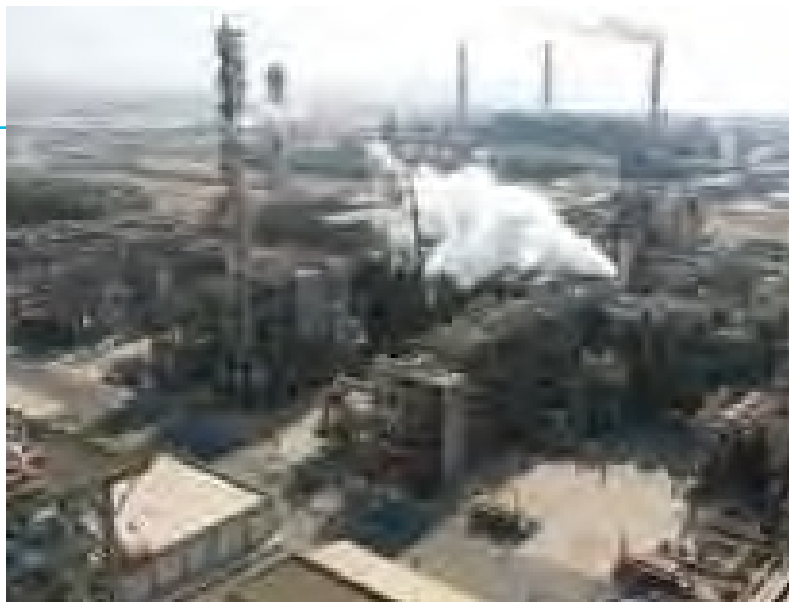
エタンクラッカー（2008年12月）
