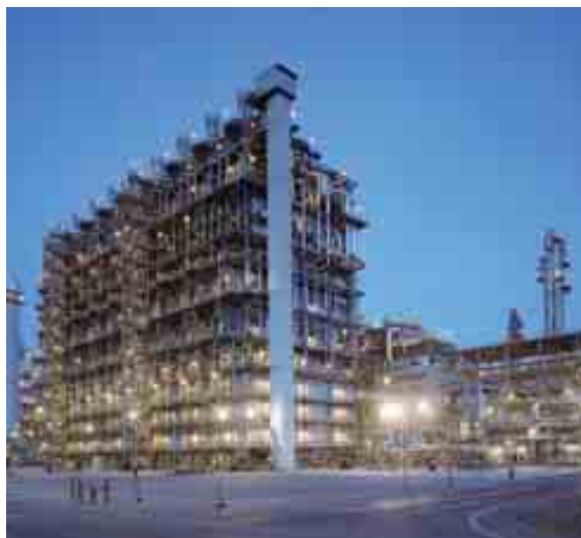
エタンクラッカー
