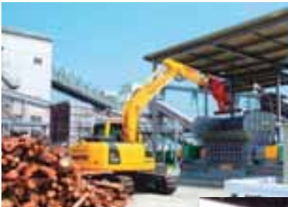
林地残材を破砕機に投入 (新居浜西火力発電所)
