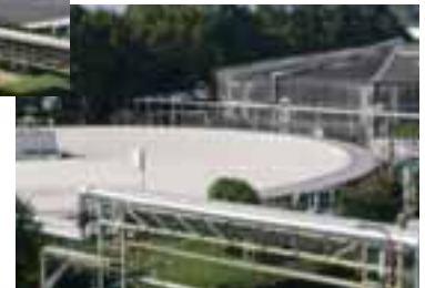
白いシートで覆った沈殿槽。
