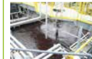
排水中と槽更新前
