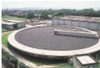
排水処理設備
