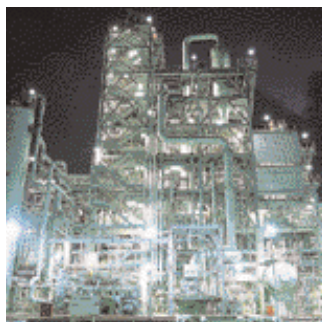
気相法ポリプロピレン製造設備
