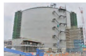
建設中の国内最大級のLNGタンク (愛媛工場敷地内)
