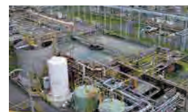
活性汚泥処理施設
