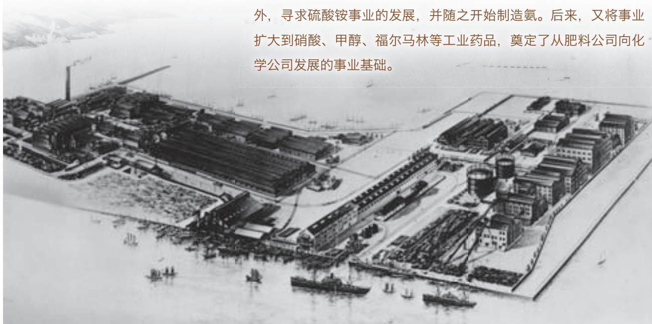
氨工厂第1期建成时的工厂全貌（右侧是氨工厂）
