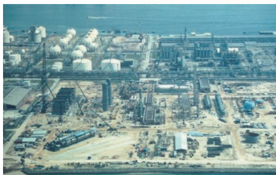
PCS第2期乙烯设备扩建工程
