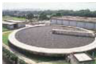
排水処理設備
