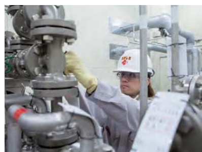
定期点検の様子
