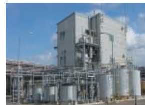
塩酸酸化の試験製造設備
