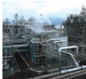
愛媛工場のカプロラクタム製造設備
