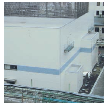
治験原薬研究棟
