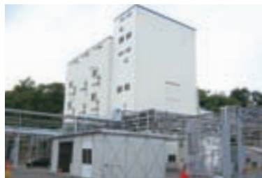
岡山プラントの医薬化学品製造設備
