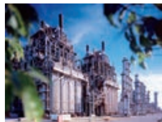
操業を停止したエチレンプラント
