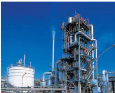
活性汚泥処理が困難な高濃度の有機物を含んだ排水については、排水処理用液中燃焼炉で燃焼させ、浄化してから、排出しています。
