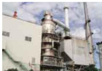
廃水などを受け入れ処理している流動床焼却炉
