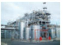
気相法カプロラクタムプロセスの装置
