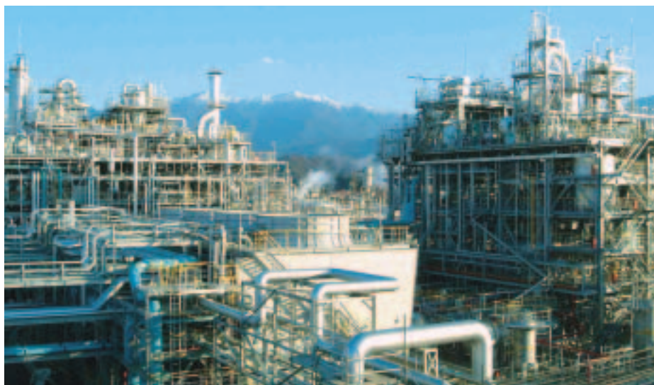
新製法によるカプロラクタム製造設備
