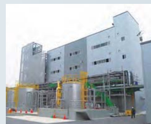
韓国・大邱に建設中のセパレータ工場
