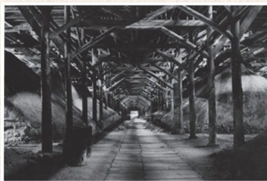
過磷酸石灰90間倉庫
