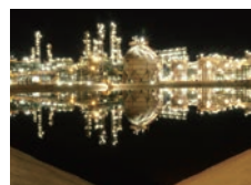
住友化学技術（プロピレンオキシド）をライセンス供与したタイの工場
