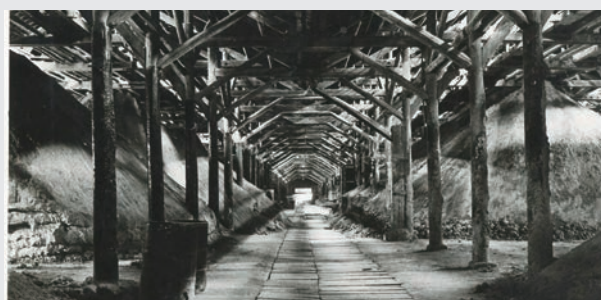
過磷酸石灰90間倉庫
