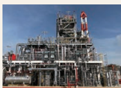
環境に配慮したエタノール由来のエチレン試験製造設備
