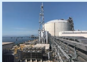
2022年3月、愛媛工場敷地内に国内最大級のLNGタンクが完成し、供給を開始
