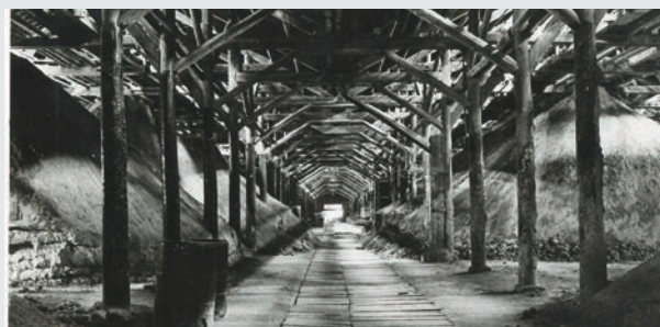
過燐酸石灰90間倉庫
