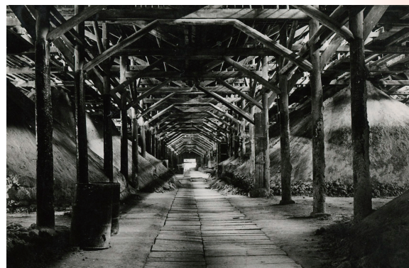
過磷酸石灰90間倉庫
