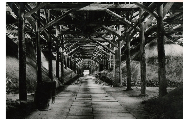
過磷酸石灰90間倉庫
