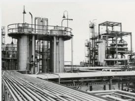
エチレン工場
