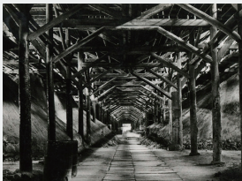
過燐酸石灰90間倉庫
