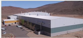
AUECC社半導体用ケミカル工場 (米国)
