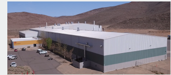
AUECC社半導体用ケミカル工場（米国）
