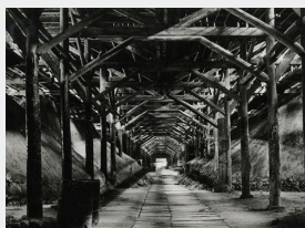
過磷酸石灰90間倉庫
