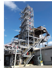
▶アクリル樹脂を熱分解し、原料のMMAモノマーに高効率で再生するPMMAケミカルリサイクルの実証設備
