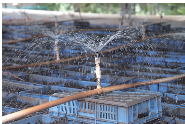
養分を比較的多く含む生活排水の特徴に合わせて、一般的な活性汚泥法ではなく、ミミズ養殖の技術を用いて処理
